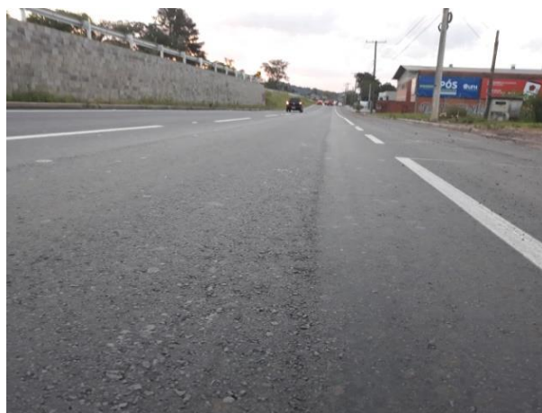
Figura 4.10 – Emenda construtiva no trecho ID 4.2
