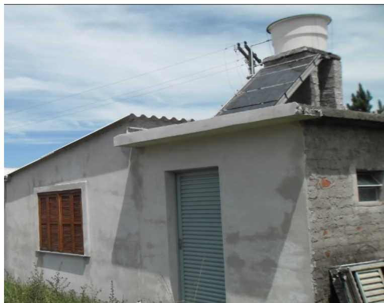
Figura 92 – Localização da placa de coletor solar no experimento
