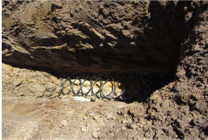
Figura 11 – Detalhe da mangueira enterrada a 5 metros de profundidade
