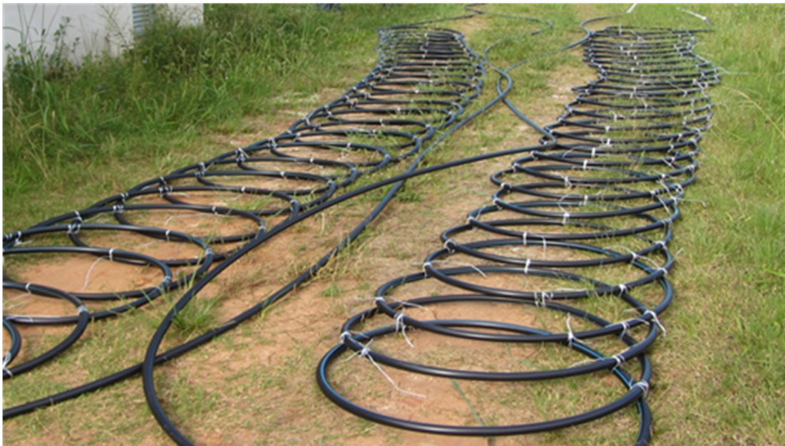
Figura 10 – Montagem do trocador geotérmico
