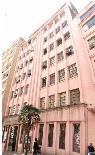
Figura 2 - Prédio do IA- UFRGS, em 2010, localizado na Rua Sr. dos Passos, 248- Porto Alegre – RS. Fonte: Arquivo Histórico do IA
