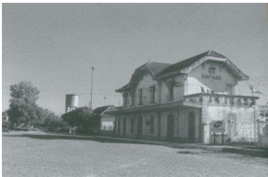
Figura 9 - Estação Ferroviária de Santiago em 2002
