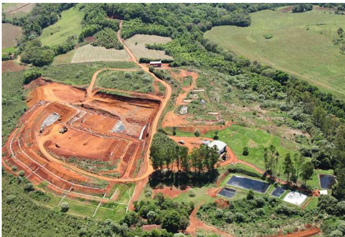
Figura 4 – Aterro Sanitário UTR I – Saudades.
