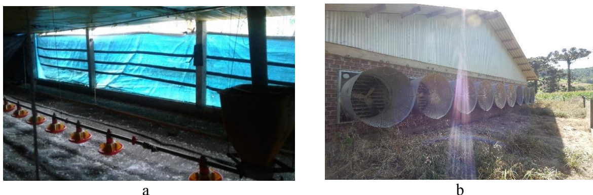
Figura 4: Aviários de média vulnerabilidade com sistema de resfriamento evaporativo por nebulização (a) e exaustão por ventilação mecânica de pressão negativa (b).
