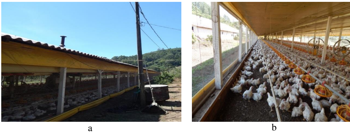
Figura 3: Aviários (a e b) de alta vulnerabilidade, sem sistemas de resfriamento evaporativo, dotados de ventilação mecânica em pressão positiva.
