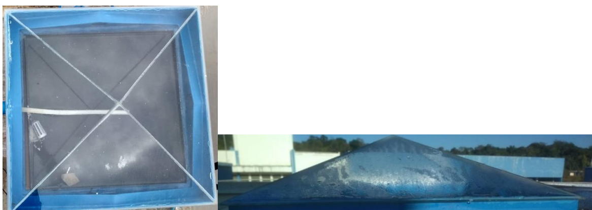
Figura 12 - Foto da cobertura de vidro
