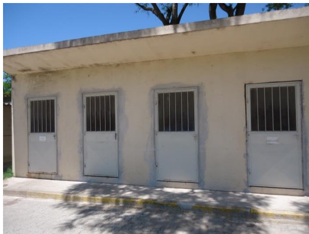
Figura 12. Casa de resíduos externa no Hospital São Francisco de Assis Fonte: Registros fotográficos da autora (2013)
