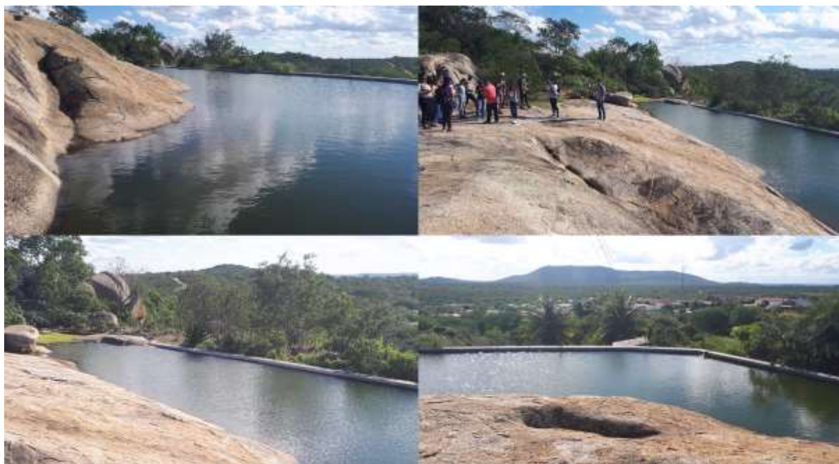
Figura 38 - Tanque de Pedra da comunidade do Lajedo de do Marinho, em Cabaceiras, PB.
