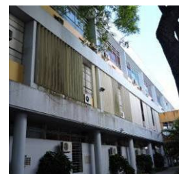
Vista parcial dos brises remanescentes. Fachada Oeste. Fonte: Acervo do autor, 2018.
