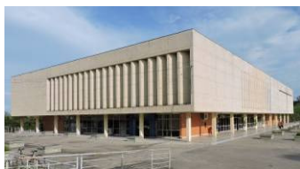
Vista geral Noroeste. Fonte: Acervo do autor, 2018.
