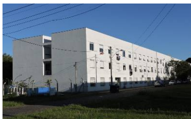
Vista geral Noroeste. Fonte: Acervo do autor, 2019.
