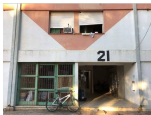
Vista de acesso a um dos blocos. Fonte: Acervo do autor, 2019.
