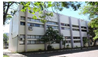
Vista parcial Noroeste. Fonte: Acervo do autor, 2019.
