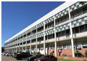
Vista geral fachada Leste Fonte: Acervo do autor, 2018.
