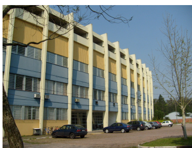
Vista parcial fachada Oeste. Fonte: Acervo do autor, 2008.
