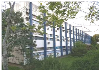
Vista parcial Sudeste. Fonte: Acervo do autor, 2019.
