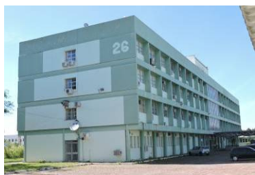
Vista geral Noroeste. Fonte: Acervo do autor, 2019.
