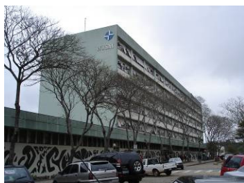
Vista parcial Noroeste. Fonte: Acervo do autor, 2008.
