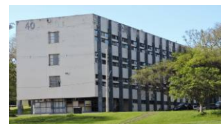
Vista parcial Noroeste. Fonte: Acervo do autor, 2019.
