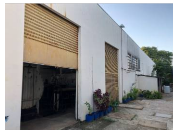
Vista parcial Sul. Fonte: Acervo do autor, 2018.
