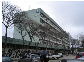
Vista parcial Noroeste. Fonte: Acervo do autor, 2008.
