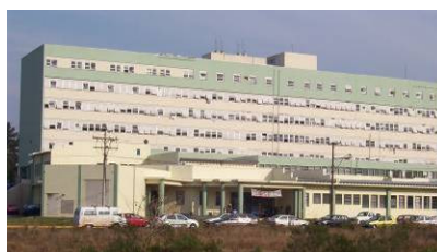
Vista Leste. Fonte: Acervo do autor, 2008.
