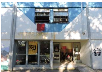
Vista de acesso a um dos blocos. Fonte: Acervo do autor, 2019.
