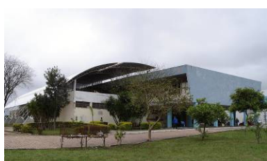
Vista geral Noroeste. Fonte: Acervo do autor, 2008.
