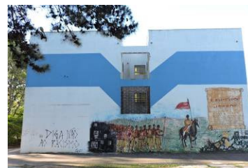
Vista fachada Sul. Fonte: Acervo do autor, 2019.
