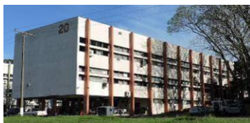
Vista parcial Sudeste. Fonte: Acervo do autor, 2019.
