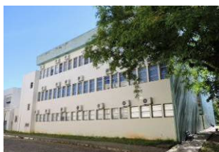
Vista parcial fachada Sudoeste Fonte: Acervo do autor, 2018.
