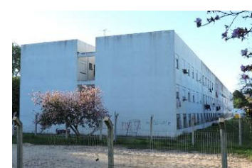
Vista parcial Sudeste. Fonte: Acervo do autor, 2019.
