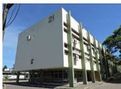
Vista parcial Sudeste. Fonte: Acervo do autor, 2019.
