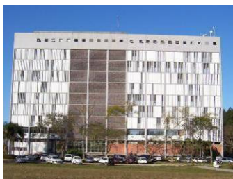
Vista Fachada Oeste. Fonte: Acervo do autor, 2016.
