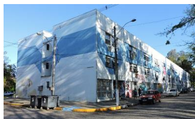
Vista geral Noroeste. Fonte: Acervo do autor, 2019.
