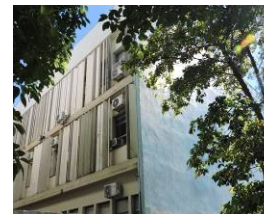
Vista parcial dos brises remanescentes. Fachada Oeste. Fonte: Acervo do autor, 2018.
