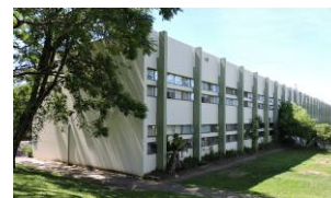
Vista parcial Noroeste. Fonte: Acervo do autor, 2019.
