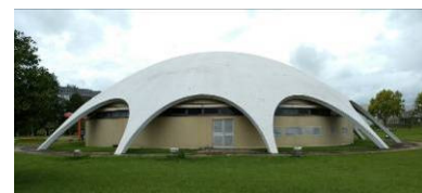
Vista parcial Noroeste. Fonte: Acervo do autor, 2019.
