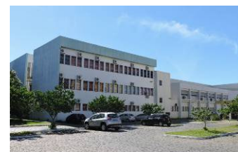
Vista parcial fachada Nordeste. Fonte: Acervo do autor, 2018.
