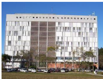
Vista Fachada Oeste. Fonte: Acervo do autor, 2016.
