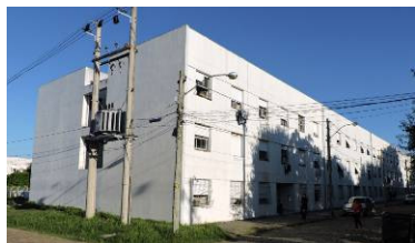
Vista parcial Noroeste. Fonte: Acervo do autor, 2019.
