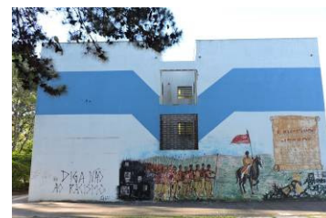
Vista fachada Sul. Fonte: Acervo do autor, 2019.
