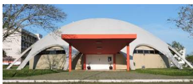
Vista Leste. Fonte: Acervo do autor, 2019.
