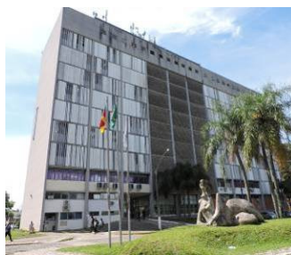
Vista geral Noroeste. Fonte: Acervo do autor, 2018.
