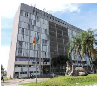
Vista geral Noroeste. Fonte: Acervo do autor, 2018.
