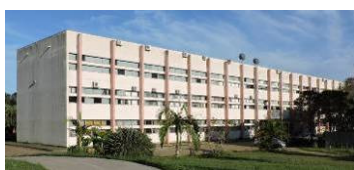
Vista parcial Sudeste. Fonte: Acervo do autor, 2019.
