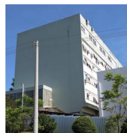
Vista parcial Sudeste. Fonte: Acervo do autor, 2019.
