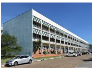
Vista geral fachada Sudeste. Fonte: Acervo do autor, 2018.
