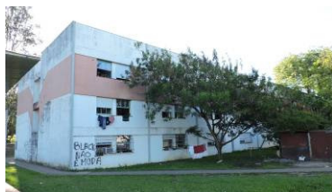
Vista parcial Sudeste. Fonte: Acervo do autor, 2019.
