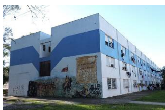
Vista parcial Sudeste. Fonte: Acervo do autor, 2019.
