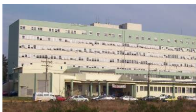
Vista Leste Fonte: Acervo do autor, 2008.
