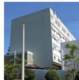
Vista parcial Sudeste Fonte: Acervo do autor, 2019.
