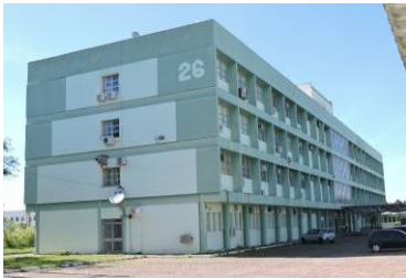
Vista geral Noroeste. Fonte: Acervo do autor, 2019.
