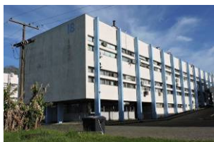
Vista parcial Sudeste. Fonte: Acervo do autor, 2019.
