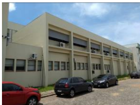
Vista parcial fachada Oeste Fonte: Acervo do autor, 2018.
