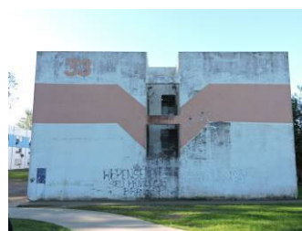
Fachada Sul. Fonte: Acervo do autor, 2019.
