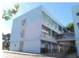
Vista parcial Noroeste. Fonte: Acervo do autor, 2018.
