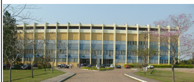
Vista parcial fachada Oeste. Fonte: Acervo do autor, 2008.
