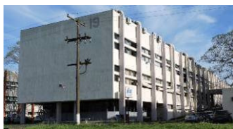
Vista parcial Sudeste. Fonte: Acervo do autor, 2019.
