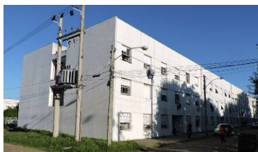
Vista parcial Noroeste. Fonte: Acervo do autor, 2019.
