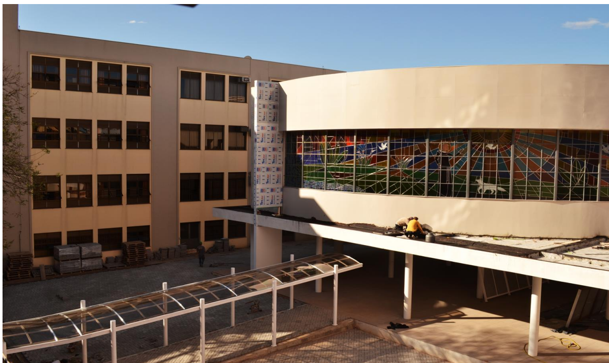
FIGURA 13 – Construção Prédio 15/ Conjunto III
