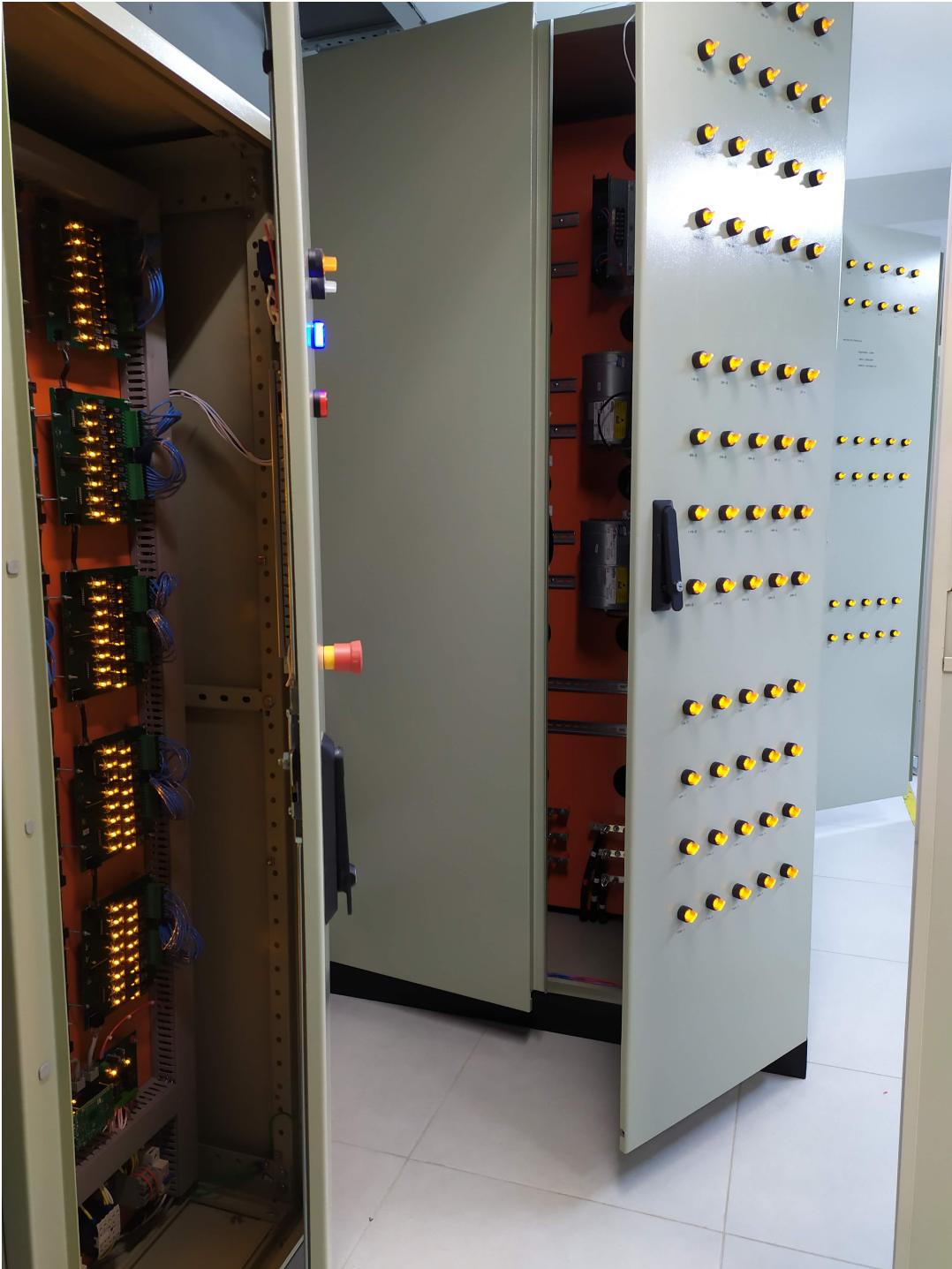
Figura 4.4 – Controlador em montagem final
