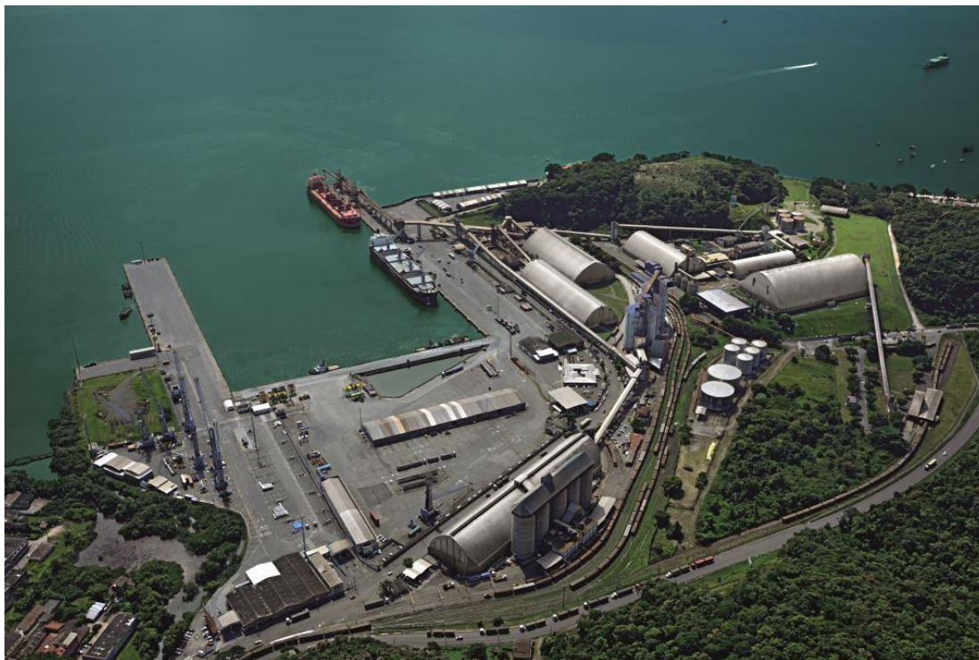
Ilustração 13: Estrutura atual do Porto de São Francisco do Sul
