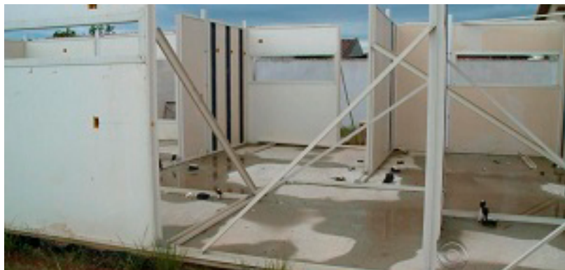
Figura 7 – Interior de obra inacabada de creche – Proinfância
