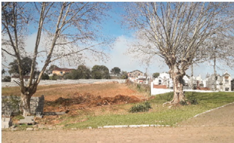
Fotografia 9 – Obras no Cemitério
