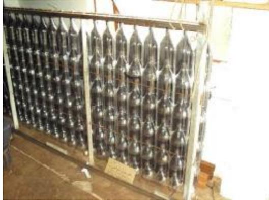
Figura 30: Painel solar de garrafas plásticas em construção, para uma residência em Panambi-RS, Bairro Erica. Foto da Autora, 2010.
