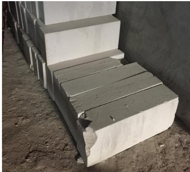
Figura 4 – Blocos de concretos danificados.
