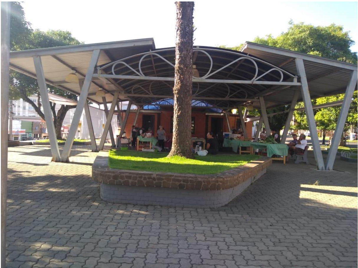
Figura 20 - Pavimentação da Praça Manoel Alvarenga localizada no centro de Júlio de Castilhos/RS.
