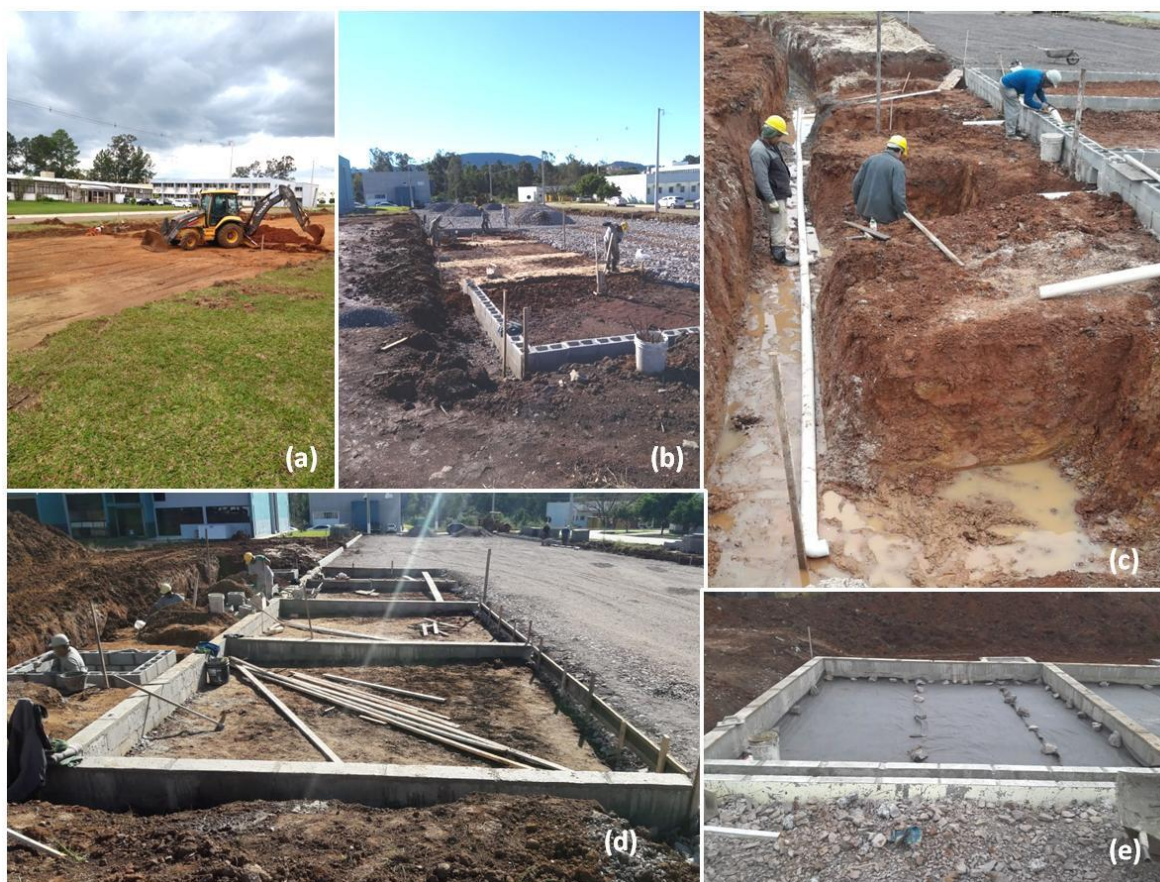
Figura 3.25 – Etapas da construção do estacionamento. Ajuste do terreno (a); vedação das vagas permeáveis (b); tubulação para escoamento superficial (c); construção das caixas de alvenaria (d); assentamento da manta geotêxtil.
