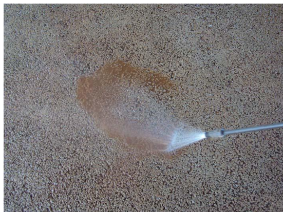
Figura 2.9 – Segunda passagem da bomba de limpeza no concreto permeável
