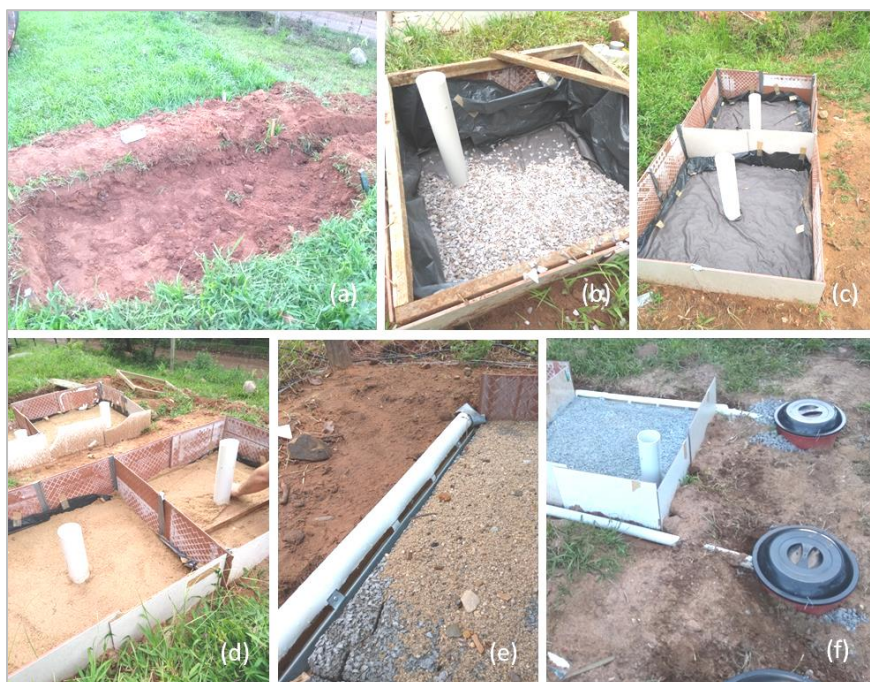
Figura 3.16 – Sequência de construção dos módulos experimentais. (a) escavação; (b) tubo e brita; (c) manta geotêxtil; (d) assentamento; (e) calha de captação; (f) baldes de reservação.
