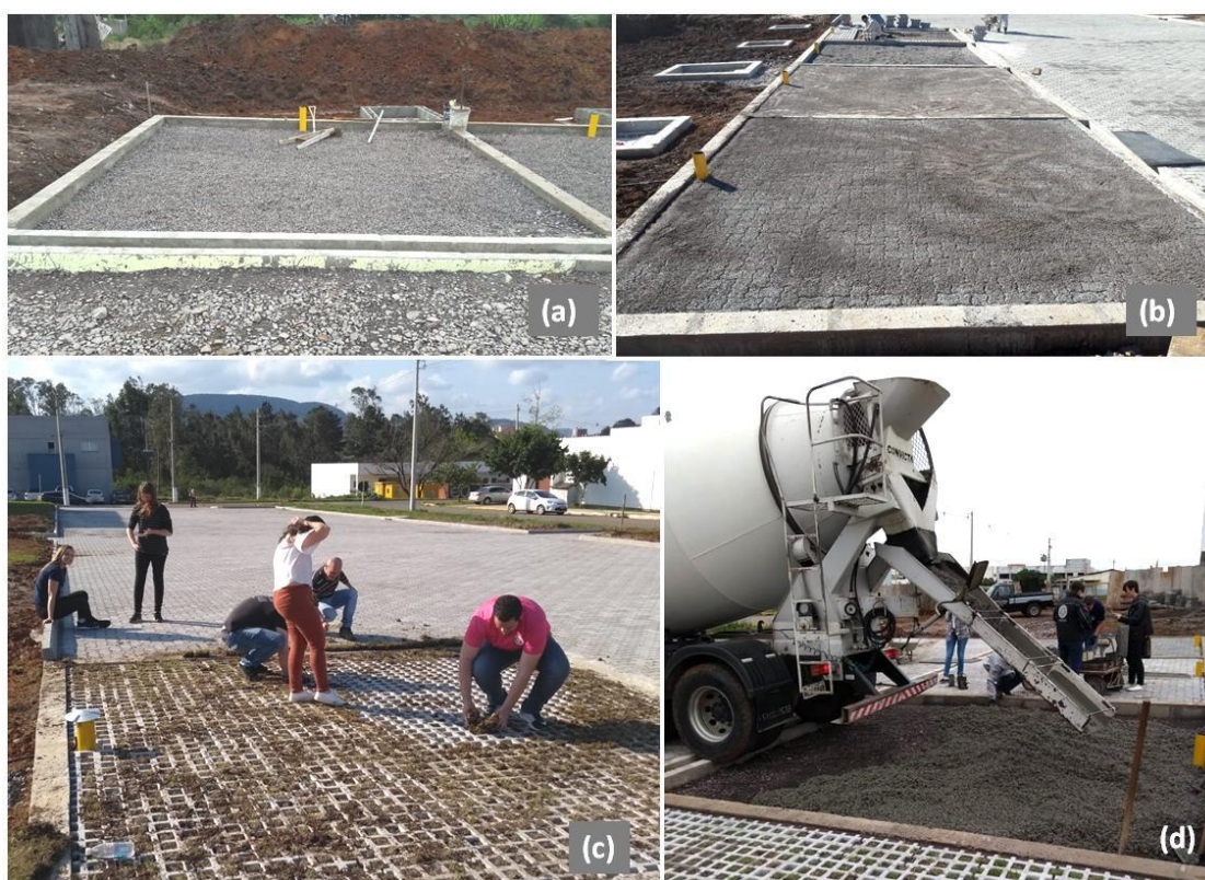
Figura 3.26 – Etapas da construção do estacionamento. Base granular (a); assentamento e rejuntamento dos blocos (b); plantio da grama (c); execução do concreto permeável (d).
