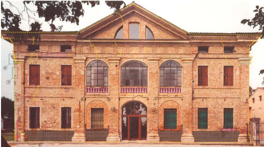
Figura 27 – Fonte: Comune di Quinto Vicentino. Villa Thiene (Andrea Palladio), Il Restauro. Analisi critico-stratigrafica, progetto e interventi parziali di restauro. Thiene, 2000
