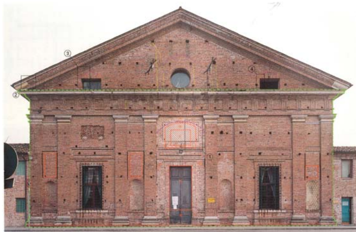
Figura 28 – Fonte: Comune di Quinto Vicentino. Villa Thiene (Andrea Palladio), Il Restauro. Analisi critico-stratigrafica, progetto e interventi parziali di restauro. Thiene, 2000
