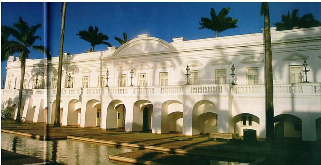
Figura 7 Fachada principal do Palácio dos Leões
