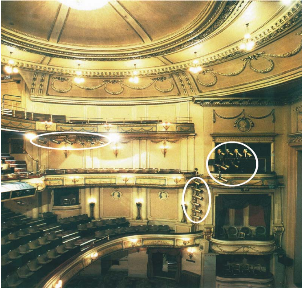
Figura 17 Vista do interior do teatro, no detalhe as varas de iluminação frontal, com seus refletores “modernos” que pintados de dourado procuram se mimetizar com o ambiente, diminuindo assim o seu impacto.
