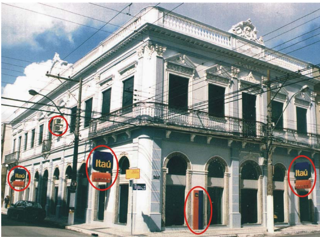
Figura 20 Vista geral do prédio do Banco Itaú, no detalhe podemos observar “letreiros publicitários” e sua influência na fachada, bem como o aparelho de ar condicionado instalado no balcão da entrada principal .
