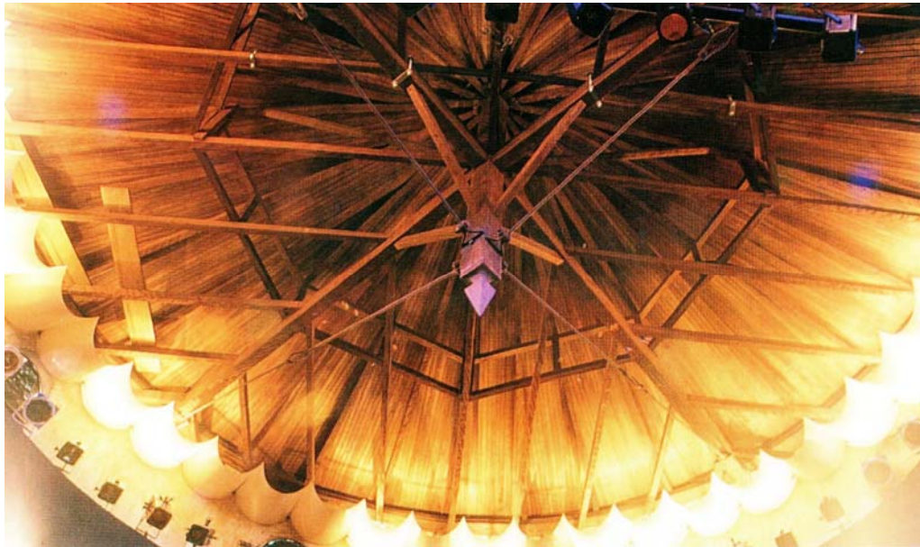
Figura 11 Vista interna do telhado, que foi mantido conforme o original havendo, apenas, a inclusão da iluminação cênica .
