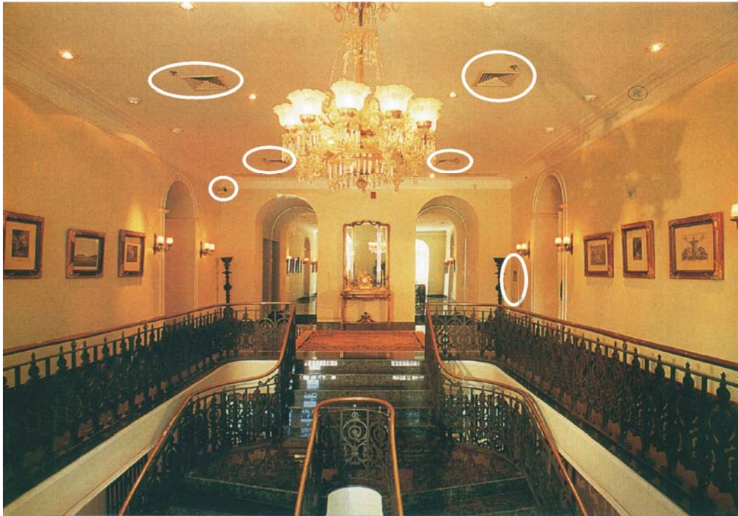
Figura 8 Ala residencial do Palácio dos Leões em sua grande parte preservada. No detalhe podemos observar os difusores de ar condicionado, as câmeras de vigilância, as caixas de mangueiras contra incêndio, bem como os sprinklers, sendo estes elementos, ditos “modernos”, plenamente integrados ao ambiente.
