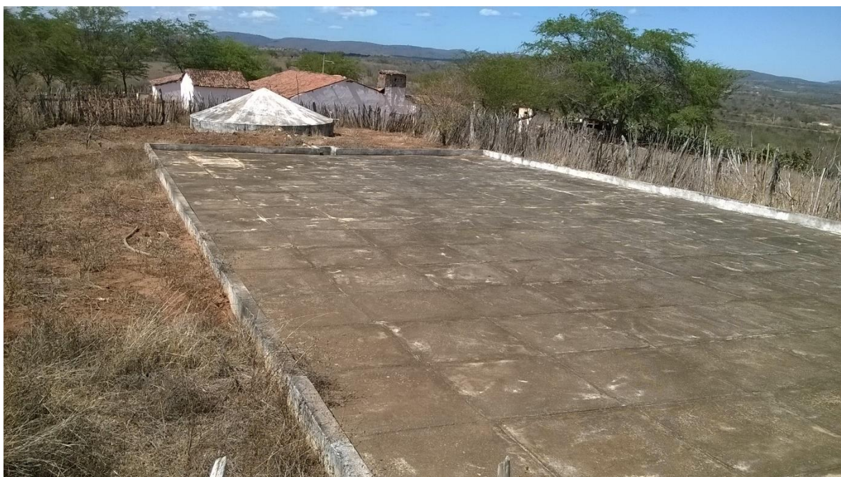
Figura 16 – Cisterna tipo calçadão na comunidade Capivara III. Solânea - Brasil.
