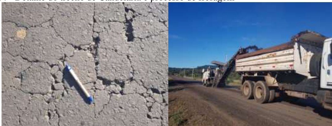
Figura 14 - Detalhe do trecho de Candelária e processo de fresagem
