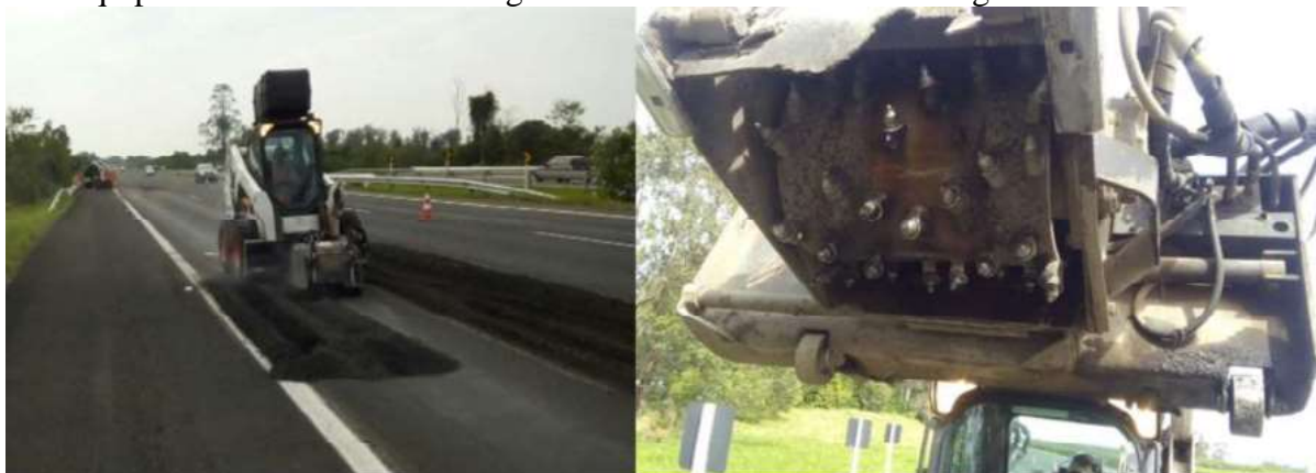
Figura 16 - Equipamento utilizado na fresagem e detalhe do tambor de fresagem
