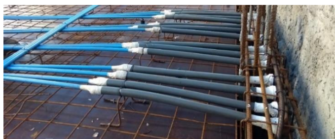
Figura 10 - Posicionamento das cordoalhas e fixação das placas de ancoragem.
