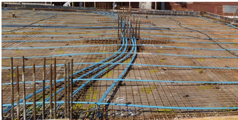
Figura 21 - Cordoalhas posicionados em curva.
