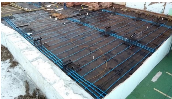
Figura 8 - Laje com protensão não aderente montada em um edifício.
