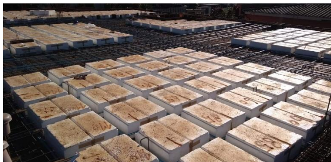
Figura 7 - Montagem de laje nervurada com protensão não aderente.
