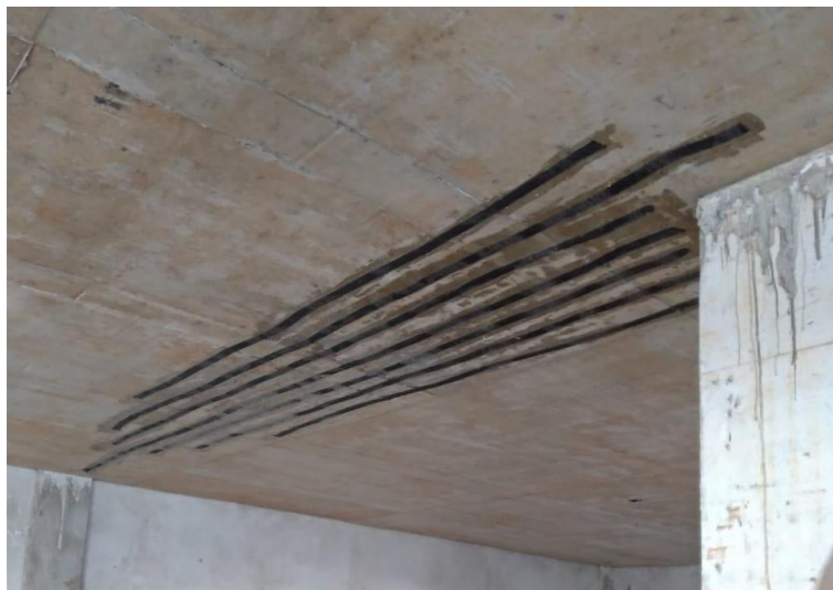
Figura 22 - Reparo estrutural em laje com protensão.
