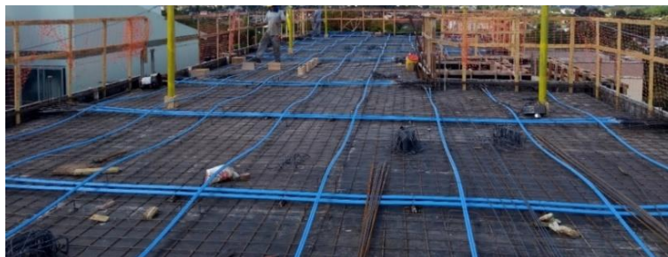
Figura 17 - Cordoalhas excêntricas posicionados na laje.
