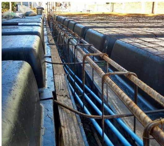
Figura 9 - Viga com protensão não aderente.
