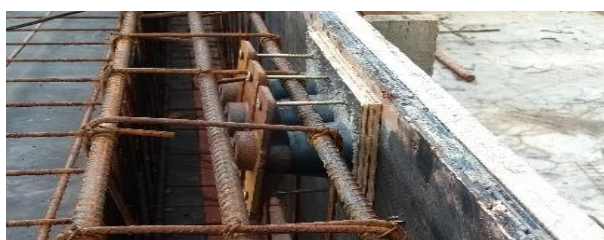
Figura 16 - Fixação da placa de ancoragem ativa na forma.
