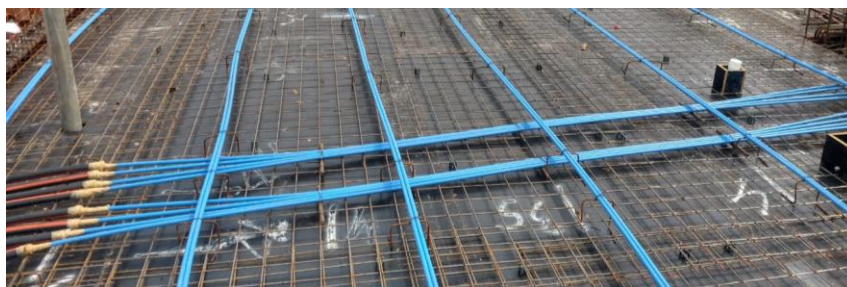
Figura 18 – Disposição de cordoalhas em uma laje.
