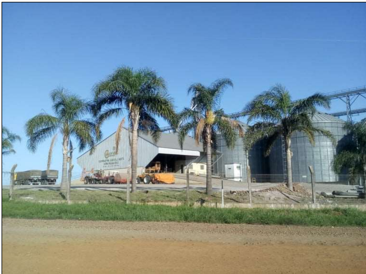
Figura 20: Unidade de recebimento e armazenamento de grãos na comunidade São Cristóvão em Nova Palma
