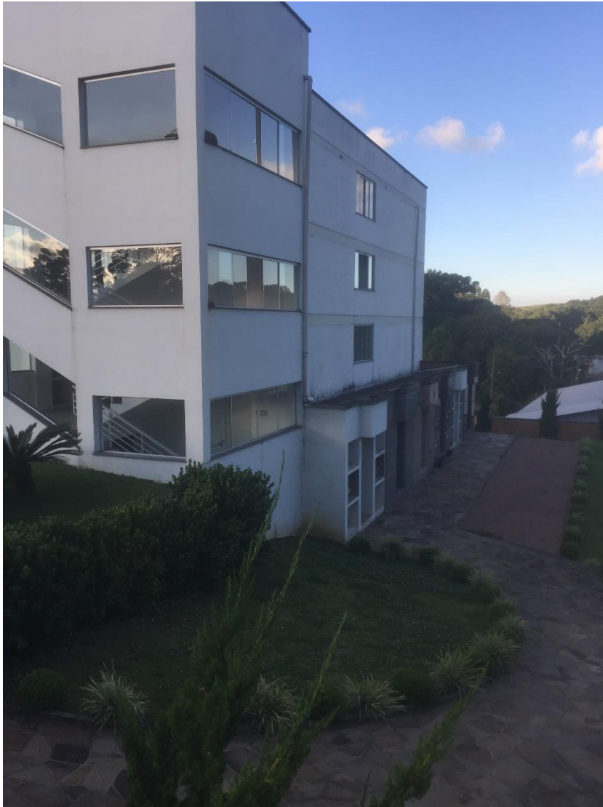
Figura 6 - Cemitério vertical municipal de Arvorezinha - RS
