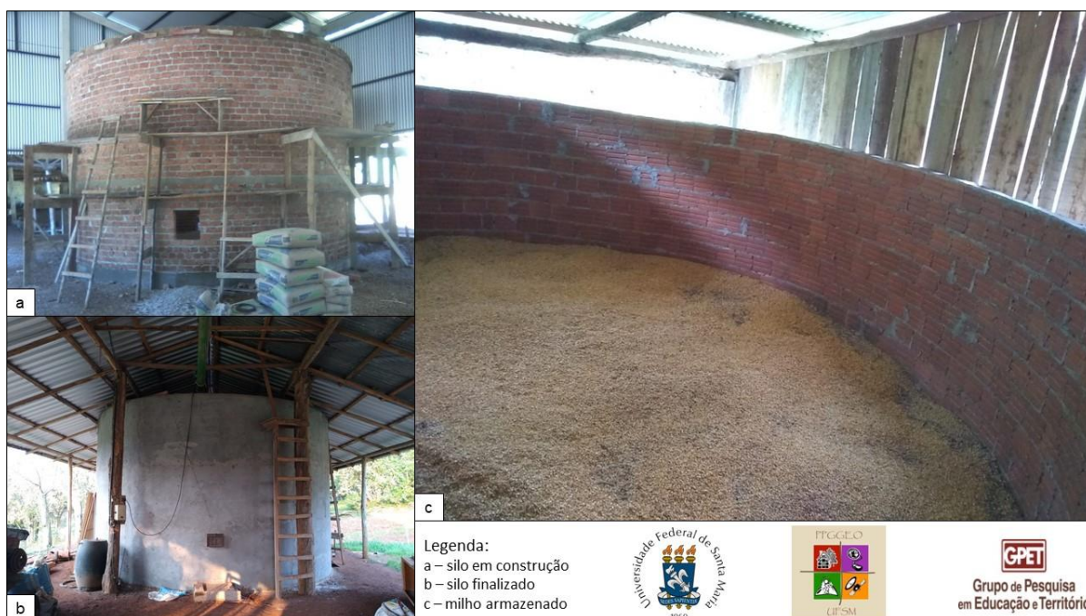
Figura 8 – Etapas da construção dos silos para secagem e armazenagem nos estabelecimentos
