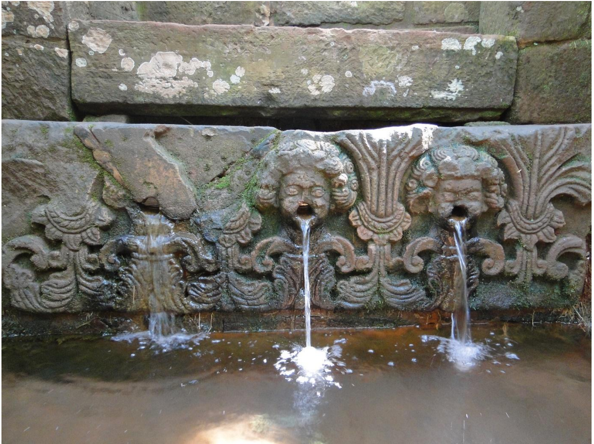
Figura 18 – Fonte missioneira (sistema de proteção de nascentes).
