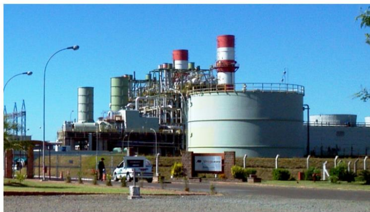
Figura 30 – Usina termoeétrica de Uruguaiana-RS
