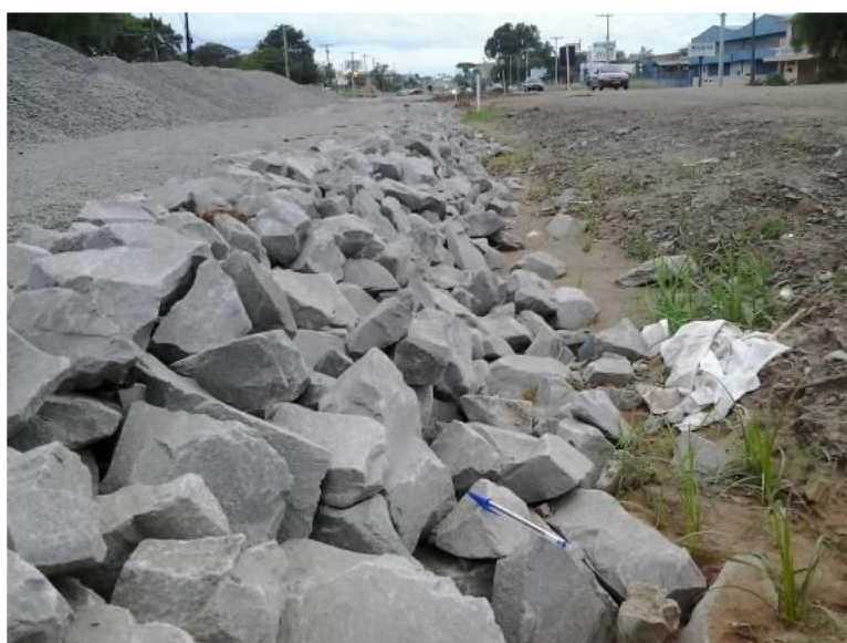
Figura 3.16 - Sub-base do trecho HB em fase de execução
