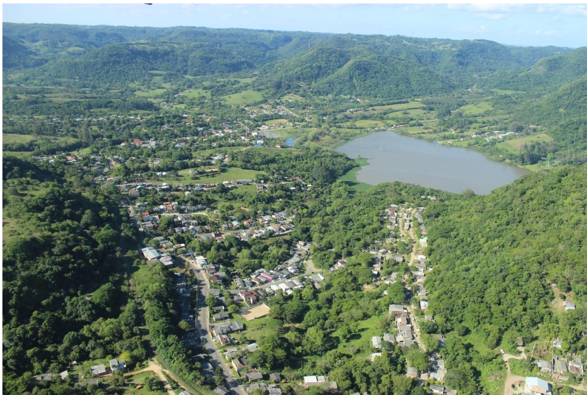
Figura 25: Foto panorâmica da barragem da DNOS
