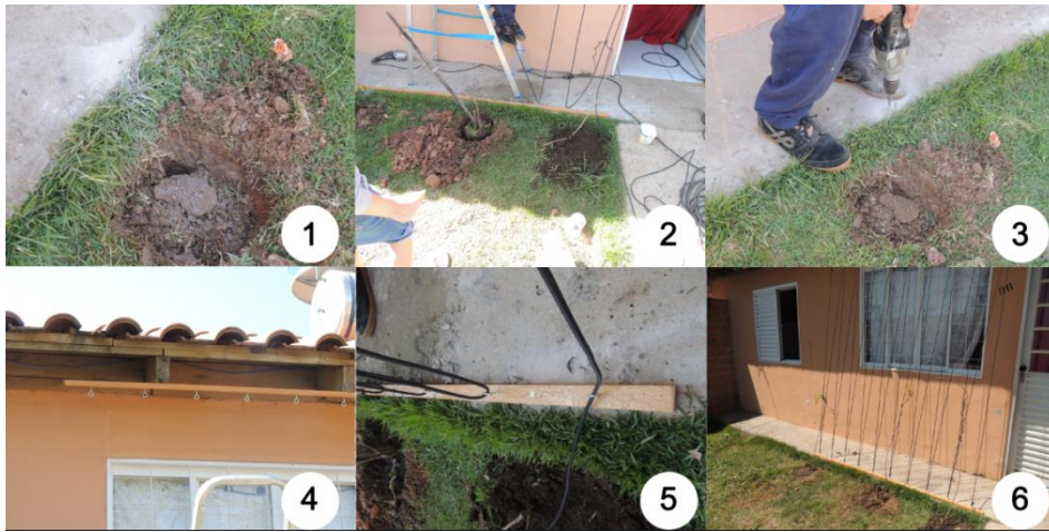
Figura 15 - Processo de execução da Cortina Verde
