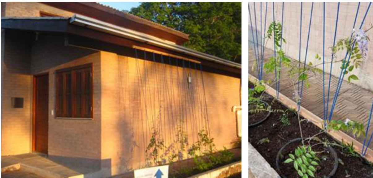
Figura 3 - Cortina Verde executada na Casa Popular Eficiente, UFSM
