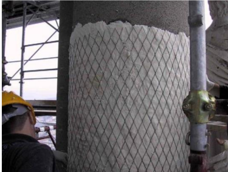
Figura 31: Aplicação da realcalinização eletroquímica em pilar de concreto.
