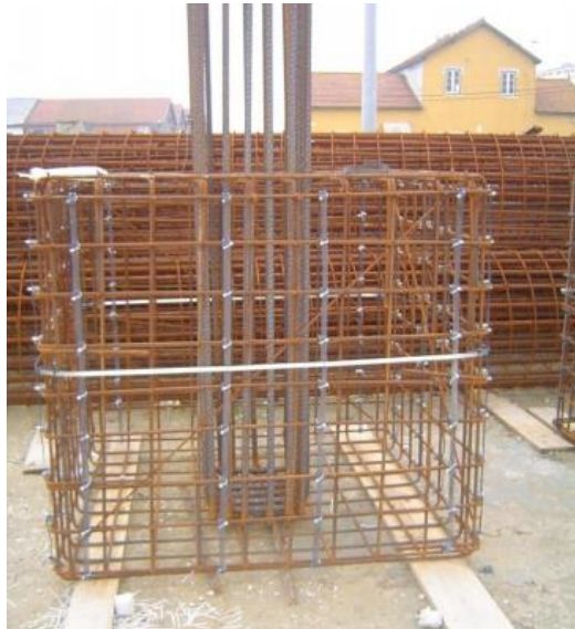
Figura 19: Malha de titânio fixada às armaduras antes da concretagem.
