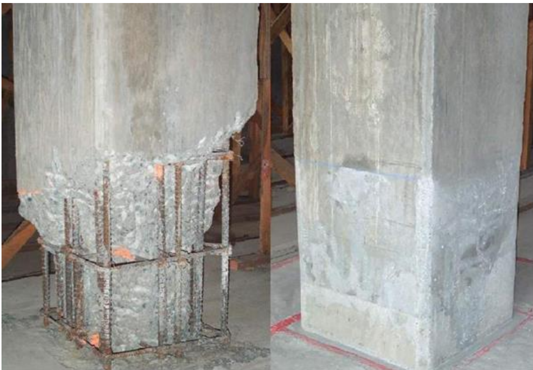
Figura 29: Reparo realizado em um pilar devido ao processo corrosivo nas armaduras.
