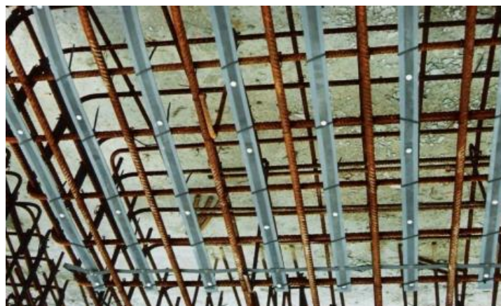
Figura 20: Malha de titânio fixada às armaduras antes da concretagem.
