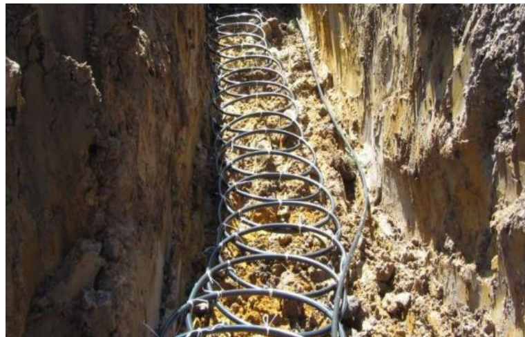
Figura 15 – Mangueira enterrada à 5 metros de profundidade.
