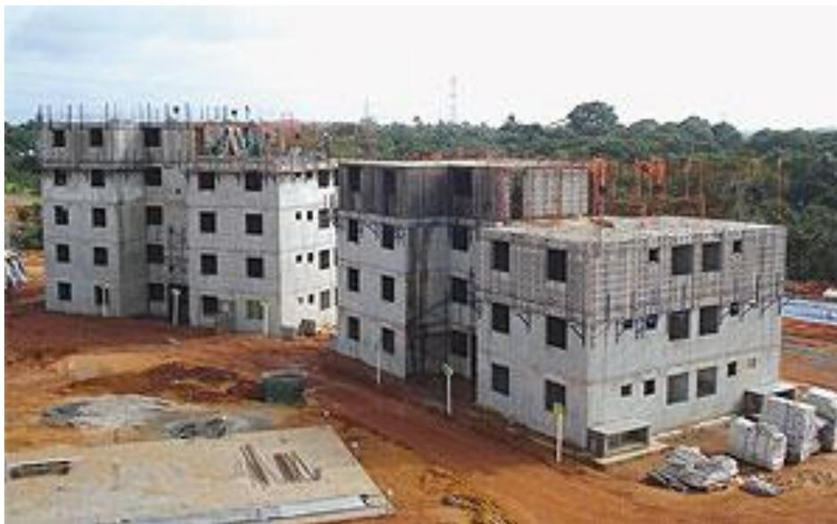
Figura 1 – Edifícios de paredes de concreto moldados in loco. Fonte: Téchne (2010).
