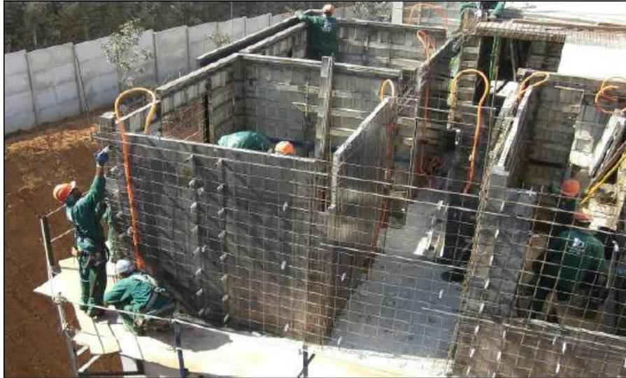
Figura 2 – Execução do sistema de paredes de concreto. Fonte: ABCP (2016).
