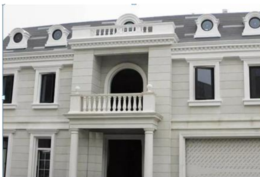
Figura 27– Fachada da “Mansão” impressa pela WinSun
