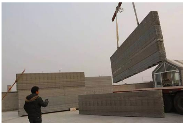
Figura 26– Montagem in loco das paredes
