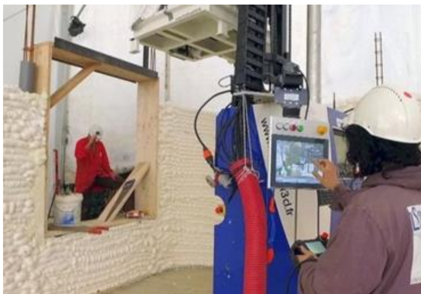
Figura 50– Detalhes construtivos da casa impressa na França
