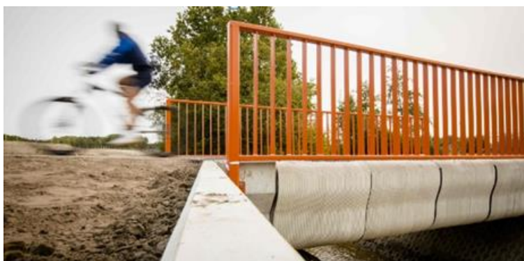
Figura 48– Inaugurada primeira ponte impressa em 3D na Holanda
