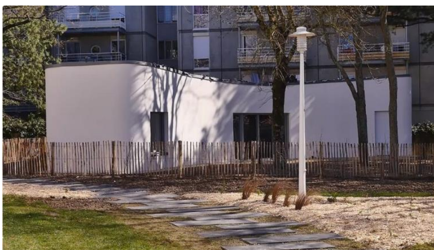
Figura 51– Primeira casa construída com impressora 3D a receber moradores
