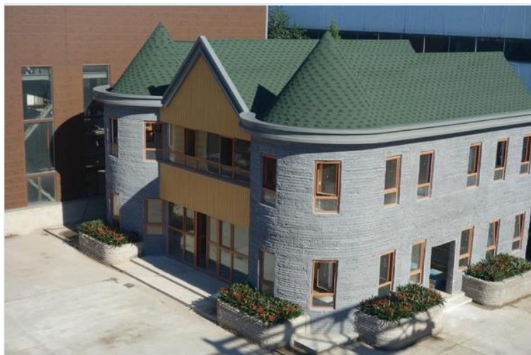
Figura 37– Vista lateral da casa impressa em 3D pela empresa HuaShang Tengda
