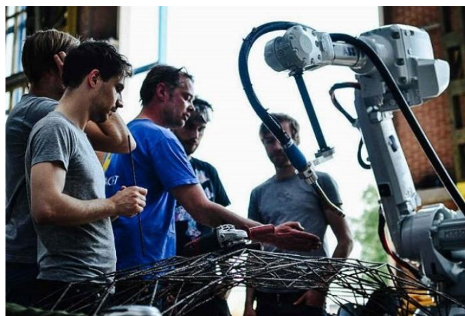
Figura 46– Robôs holandeses imprimem ponte
