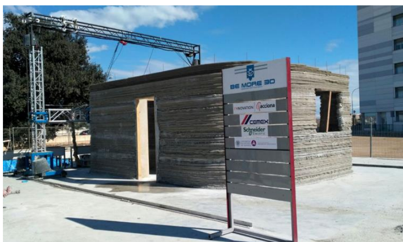
Figura 61– Construção com 24m 2 feita pela Be More 3D
