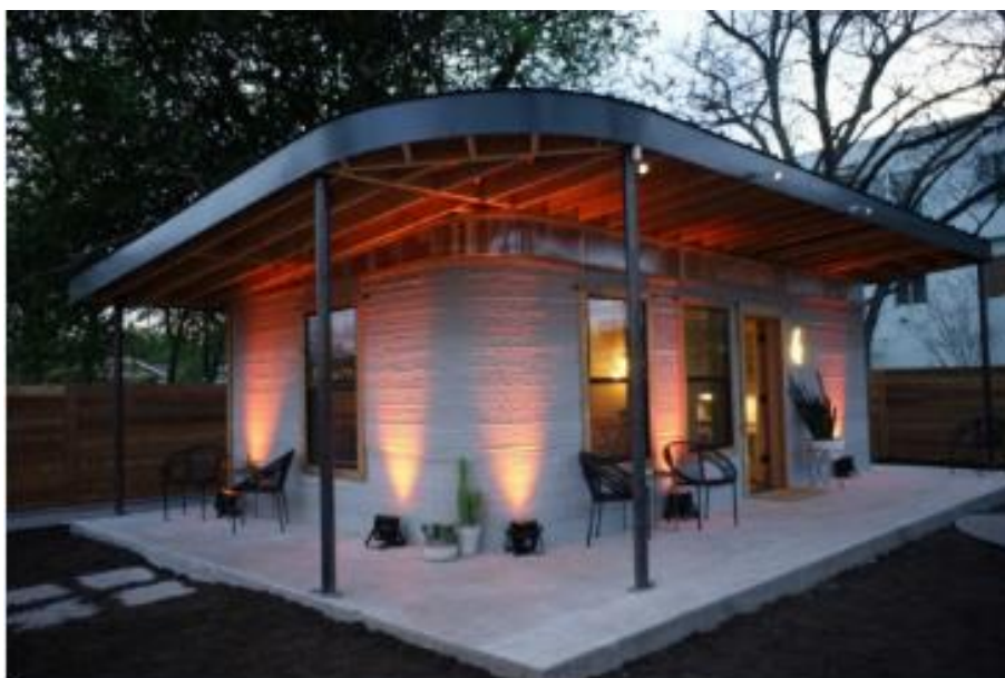
Figura 40– Casa impressa em 3D no Texas, EUA
