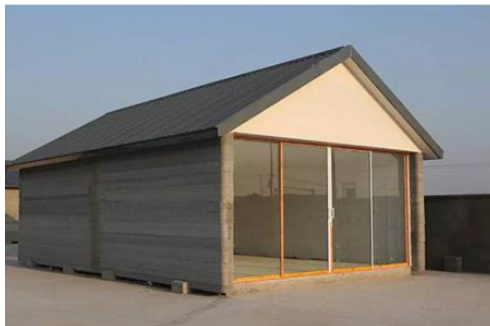
Figura 30– Abrigo impresso em 3D
