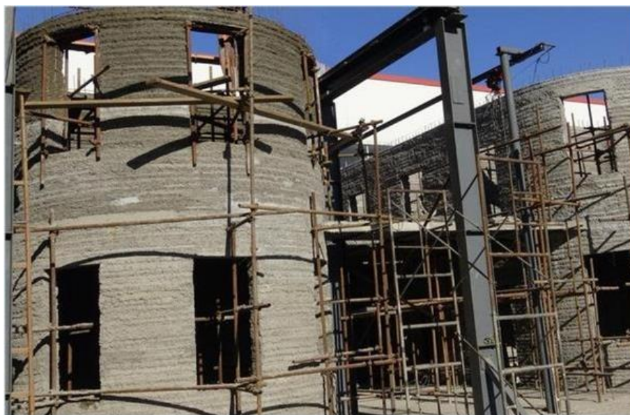
Figura 35– Fase inicial da construção da casa resistente a terremotos
