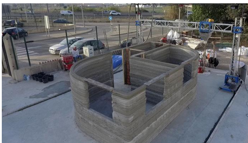
Figura 62– Detalhe da estrutura da Impressora 3D de concreto da Be More 3D
