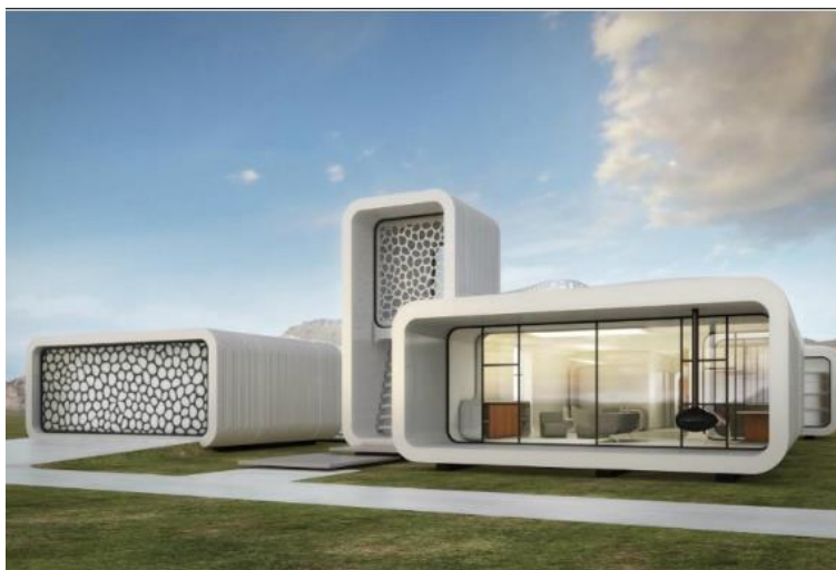
Figura 57– Primeiro escritório funcional construído por impressoras 3D
