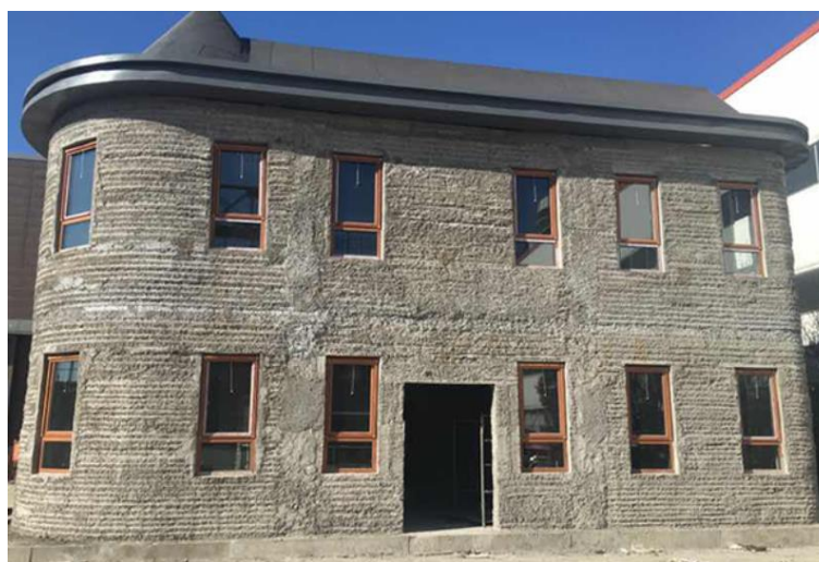
Figura 36– Conclusão da construção de casa resistente a terremotos
