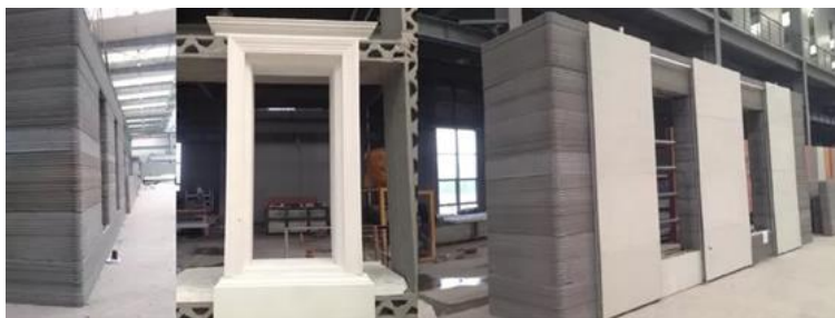
Figura 25– Paredes impressas e montadas
