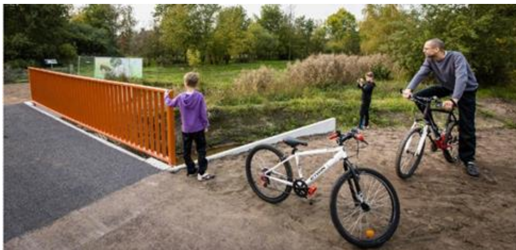
Figura 49– Inaugurada primeira ponte impressa em 3D na Holanda
