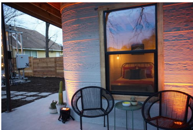
Figura 41– Casa impressa em 3D no Texas, EUA
