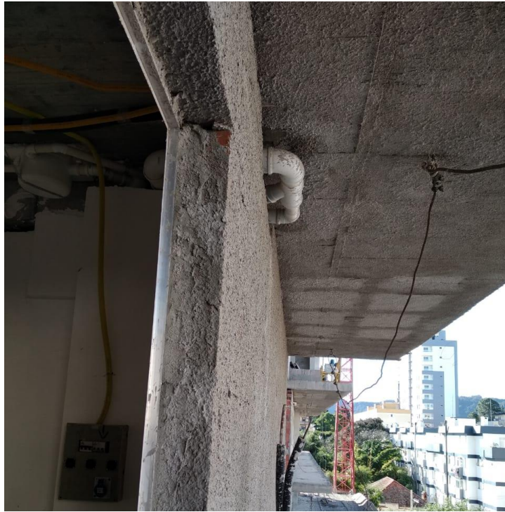
Figura 29: Elementos hidráulicos expostos na fachada lateral do edifício.
