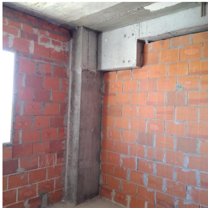
Figura 23: Reforço estrutural nos pavimentos 1 e 2.
