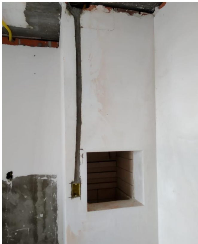
Figura 31: Retrabalhos em pontos elétricos.
