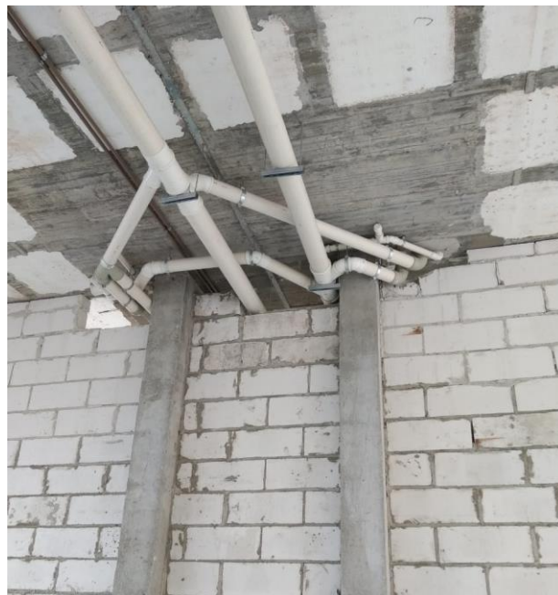
Figura 30: Elementos hidráulicos expostos na fachada lateral do edifício.
