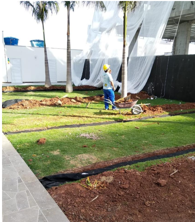
Figura 22: Execução dos drenos.
