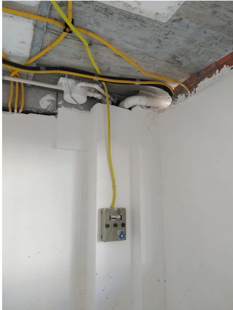
Figura 28: Peças hidrossanitárias e estruturais.
