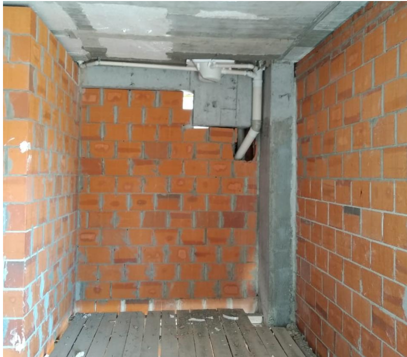
Figura 24: Reforço estrutural nos pavimentos 1 e 2.
