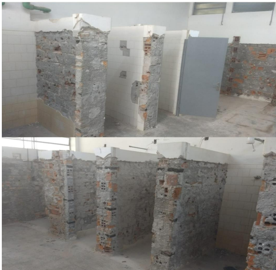
Figura 22: Detalhe construtivo de outro banheiro, vestiário.
