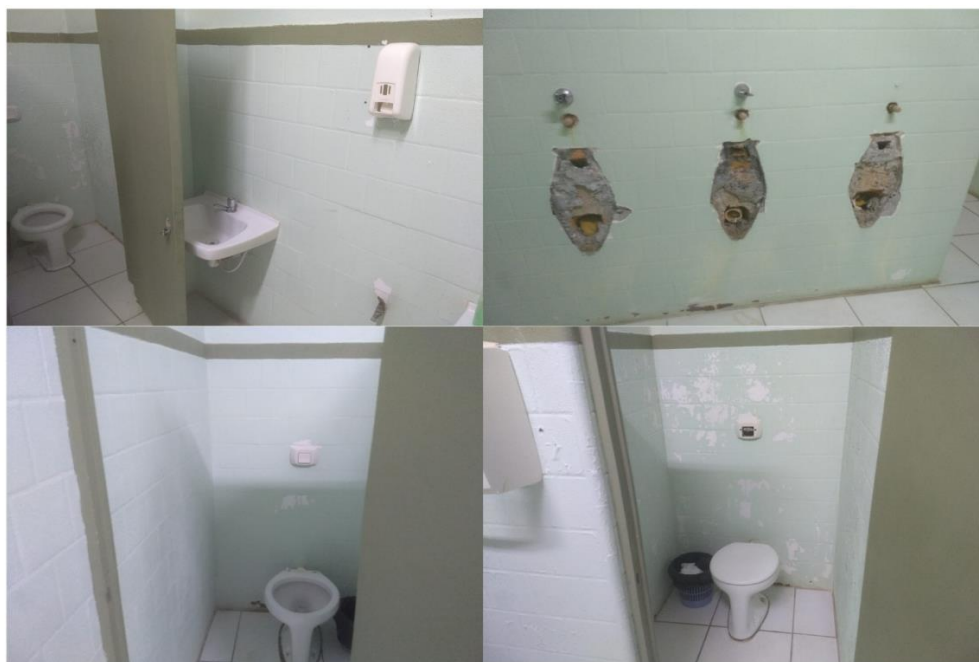
Figura 21: Banheiro térreo a ser reformado
