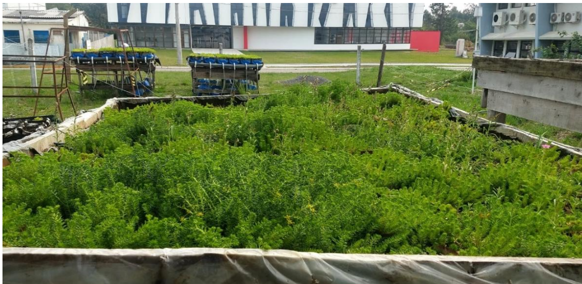
Figura 2 - Vegetação de Sedum rupestre no telhado verde
