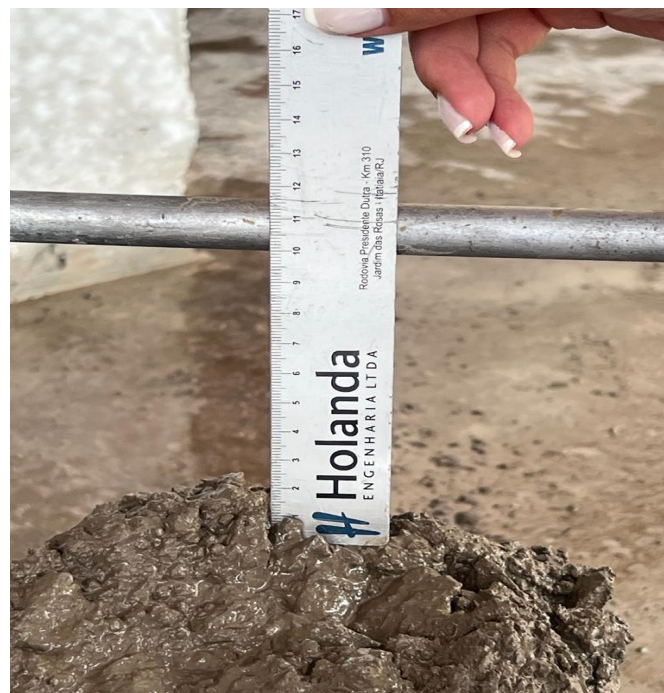
Figura 15 - Verificação do abatimento do TR.
