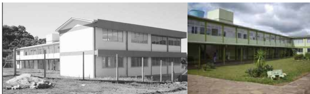
FIGURA 10 Polo com nova sede em construção (esquerda) e finalizada (direita).
