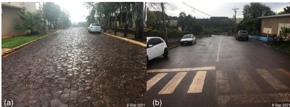
Figura 20 - Pavimento de pedras poliédricas (a) e pavimento em concreto asfáltico (b), sem defeitos, observados a campo no Distrito Trentin, Jaboticaba – RS.
