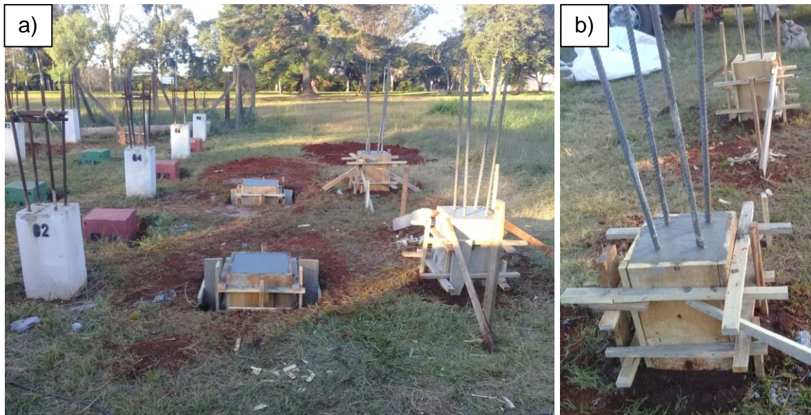
Figura 13 – Concretagem das estacas de reação e compressão de 6 m de comprimento.
