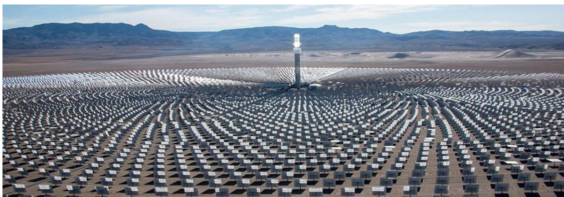
Figura 2.2 - Usina solar térmica no sul da Austrália
