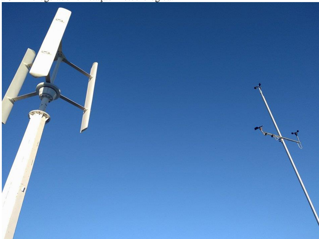
Figura 82 - Aerogerador e Estação Meteorológica.
