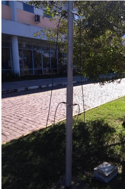
Figura 61 - Sistema instalado em um mastro de bandeira.
