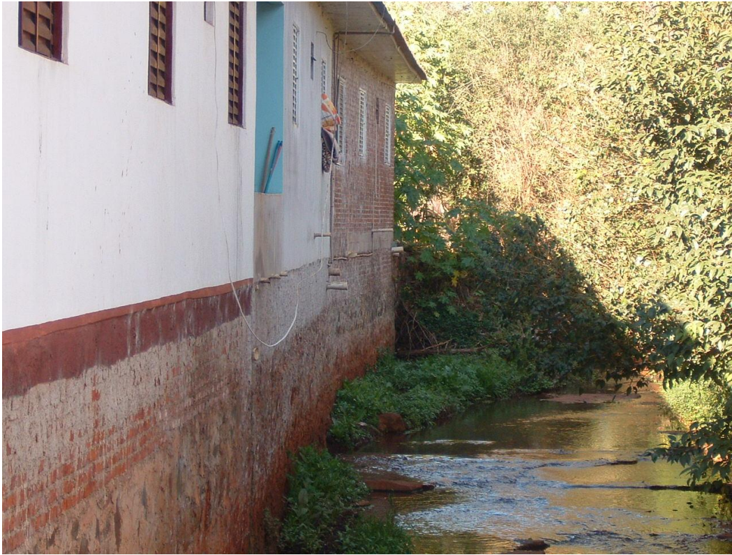
Figura 02 - Fotografia mostrando trecho do arroio Monjolo que recebe esgoto residencial urbano sem tratamento, Santo Cristo, RS.
