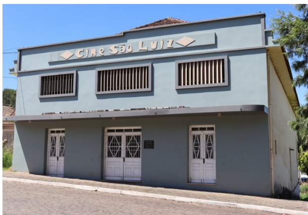
Figura 31 – Prédio do Cine São Luiz atualmente
