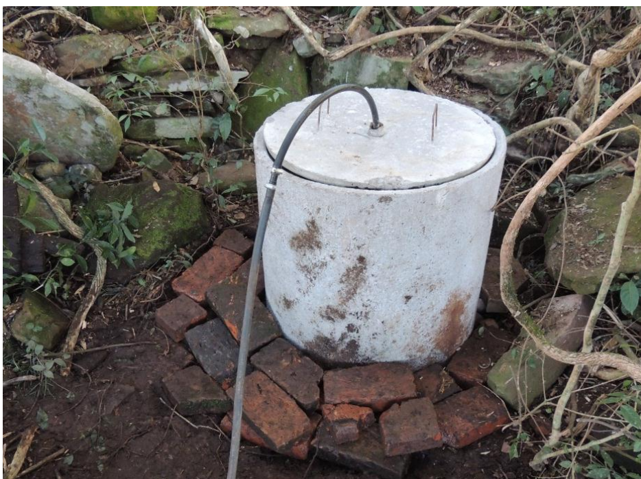
Figura 12 - Implantação do revestimento do poço com tampa, Arroio do Tigre, 2013. Fonte: Registro fotográfico de Ismael Wagner.
