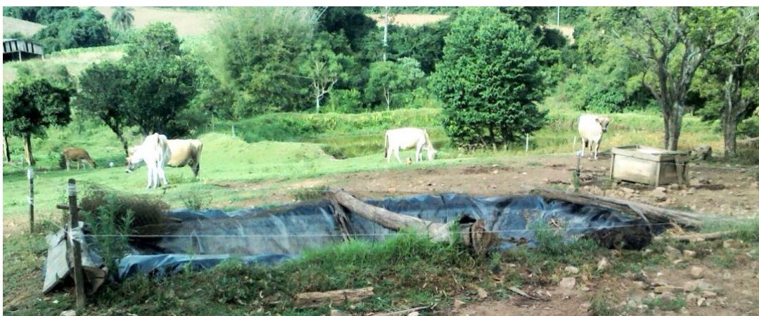
Figura 13 - implantação da esterqueira. Arroio do Tigre, 2013 Fonte: Registro fotográfico da autora.
