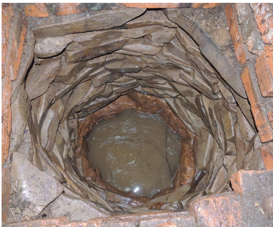
Figura 11 - Recuperação de uma nascente de encosta, Arroio do Tigre, 2013. Fonte: Registro fotográfico de Ismael Wagner.
