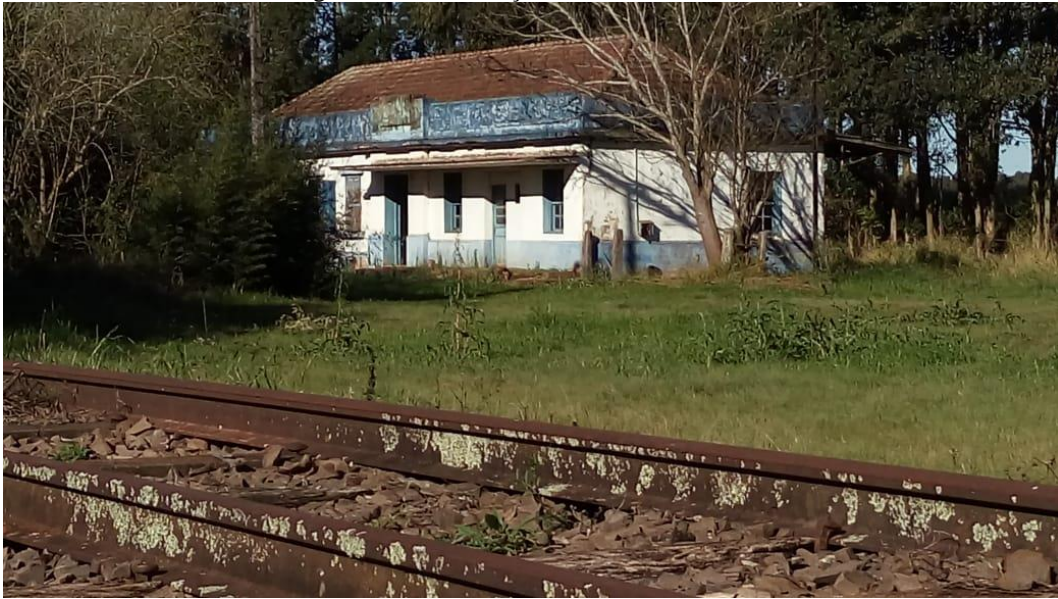
Figura 19: Foto Estação Ferroviária Belizário
