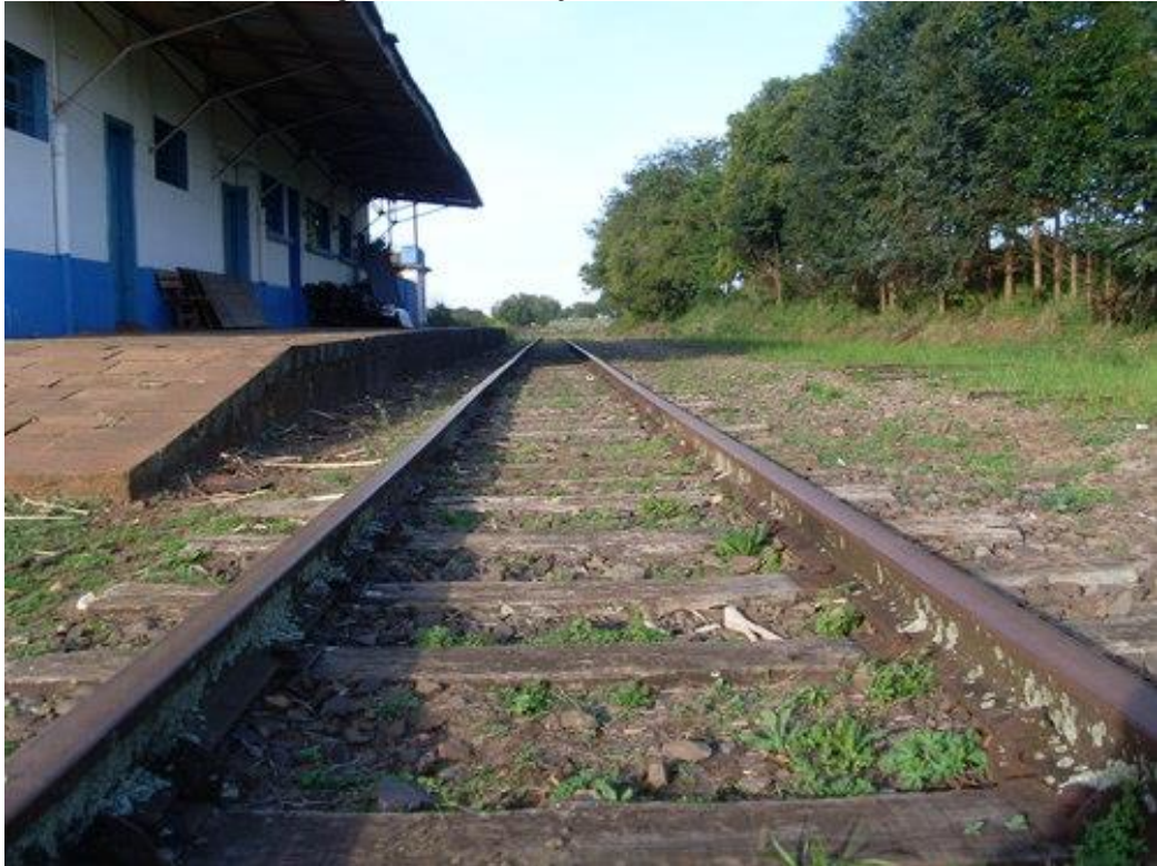
Figura 18: Foto Estação Ferroviária Belizário
