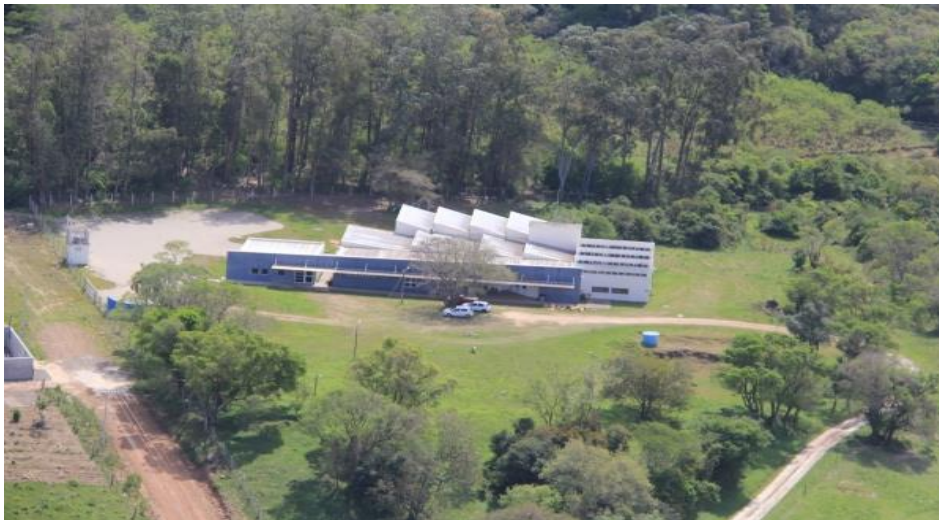
Figura 7-Prédio sede do CONDESUS junto ao Centro de Apoio de Pesquisas Paleontológicas (CAPPA) em São João do Polêsine, RS, Brasil
