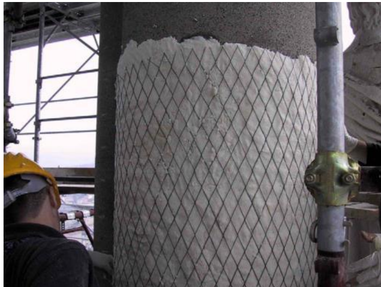
Figura 10 – Aplicação de realcalinização eletroquímica em estrutura real
