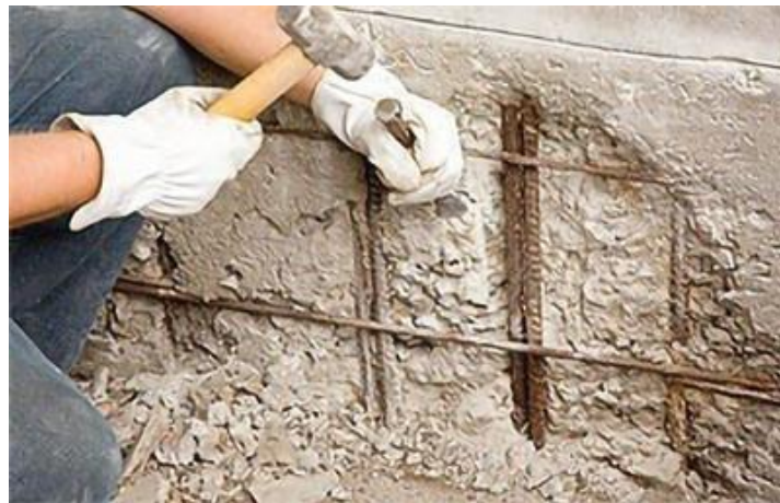
Figura 13 – Remoção do concreto desagregado
